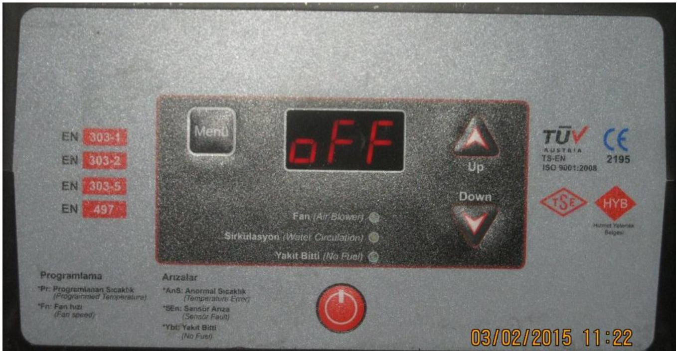
Малюнок 3. Панель управління котла RK3G
