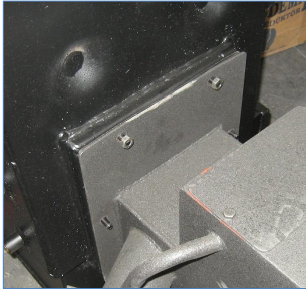
Малюнок 31. Встановлений на котлі корпус шнекової подачі.
