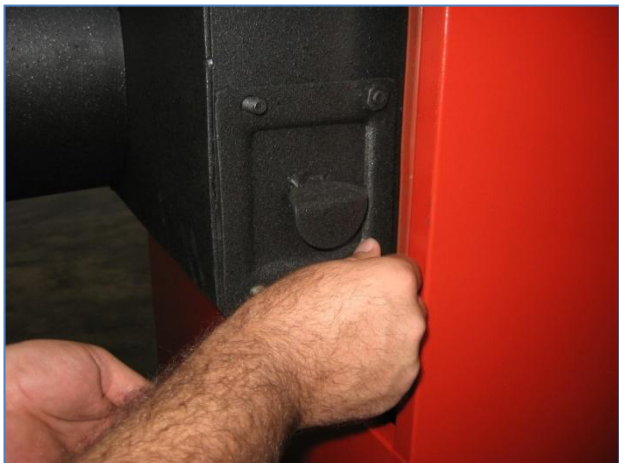
Малюнок 17. Зняття заглушки для чищення адаптера диму
